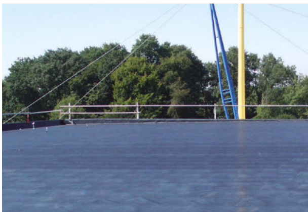
Eissporthalle, Greifath, ExtruBit Dachabdichtung, 4.000 m 2
