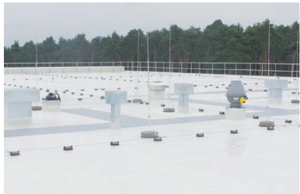
Pufas, Hann. Münden, ExtruPol Dachabdichtung, 7.100 m²
