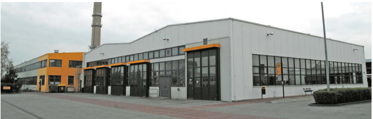
DVB Dresdner Verkehrsbetriebe AG, ExtruBit Dachabdichtung, 10.000 m 2 ; ExtruPol Dachabdichtung, 4.000 m 2
