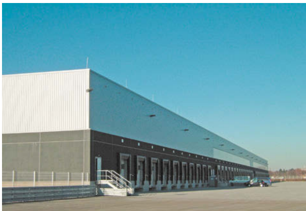
Lidl Logistikzentrum, Leverkusen, ExtruBit Dachabdichtung, 33.000 m 2
