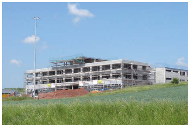
Mobotix AG Firmengebäude, Kaiserslautern ExtruPol Dachabdichtung, 6.000 m²
