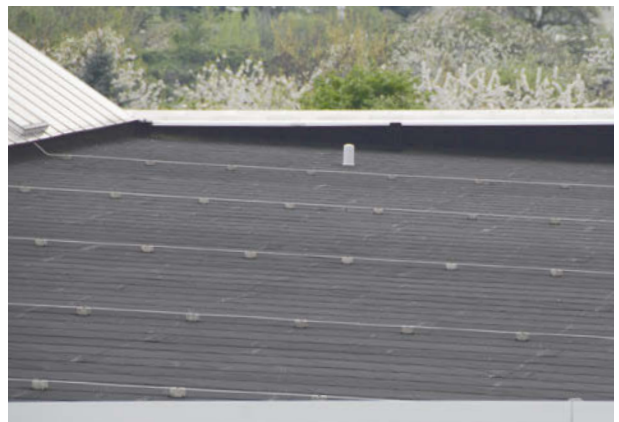
Dresdner Verkehrsbetriebe AG, Dresden, Dachabdichtung ExtruBit 10.000 m 2 und ExtruPol 6.000m 2
