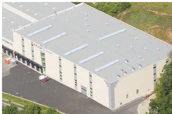
Pufas, Hann. Münden, ExtruPol Dachabdichtung, 7.100 m²
