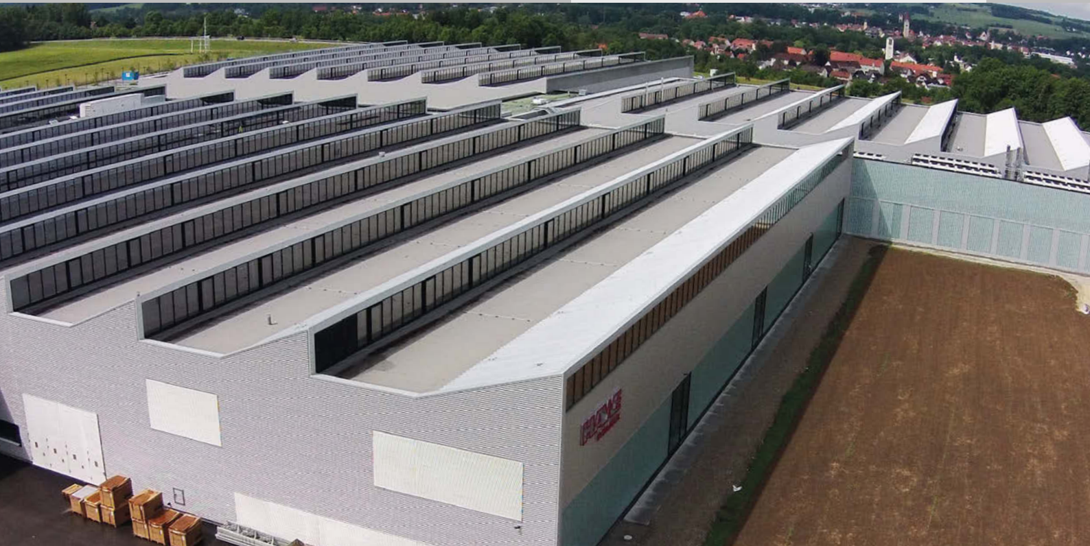
HAWE Hydraulik, Kaufbeuren ExtruPol Dachabdichtung 40.000 m 2
