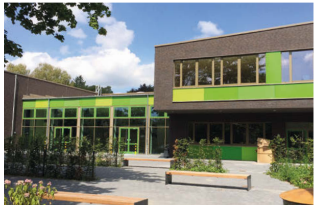
BBS Göhlbachtal, Hamburg ExtruPol Dachabdichtung, 3.000 m²
