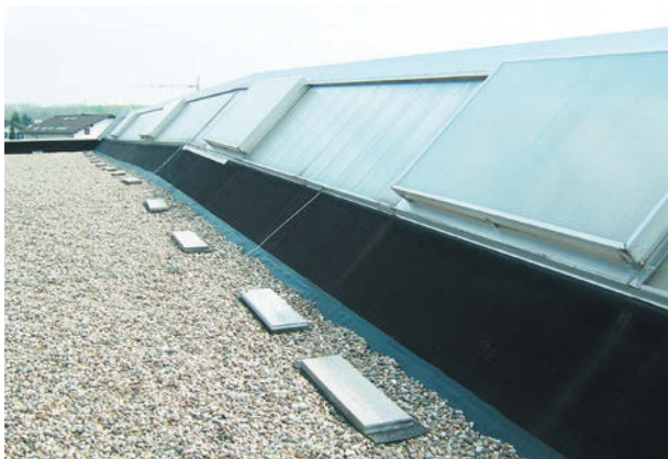
Baumarkt, Baden-Baden, ExtruBit Dachabdichtung, 4.500 m 2
