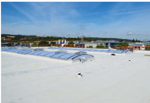
Sartorius AG, Göttingen ExtruPol Dachabdichtung 2.300 m 2
