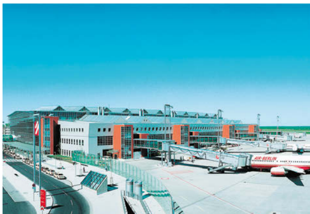
Flughafen Dresden ExtruPol Dachabdichtung, 6.350 m 2
