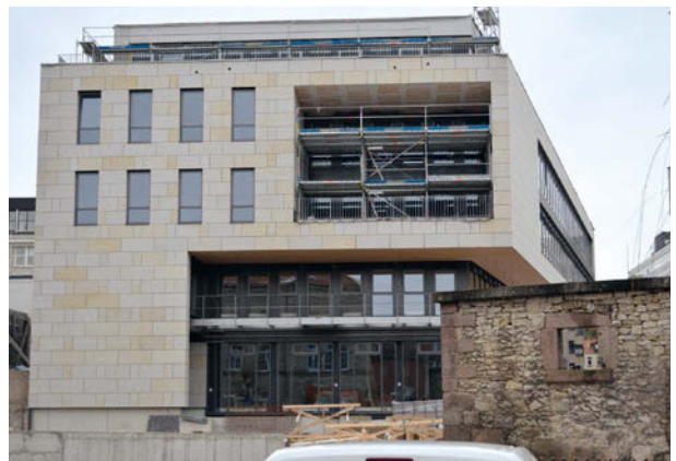
Quartier am Leinebogen, Göttingen ExtruPol Dachabdichtung 2.000 m 2
