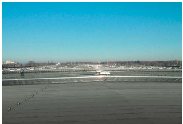
H&N-Versandlager, Hann. Münden, ExtruBit Dachabdichtung, 11.000 m 2
