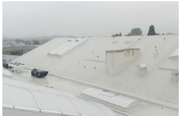
Tennishalle/Fitness, Krefeld ExtruPol Dachabdichtung, 5.000 m²
