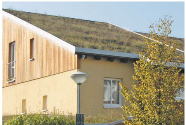
Gründach-Siedlung Bovenden, ExtruBit Dachabdichtung, 850 m 2
