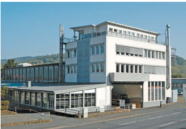
HTT, Hann. Münden ExtruPol Dachabdichtung, 4.000 m 2
