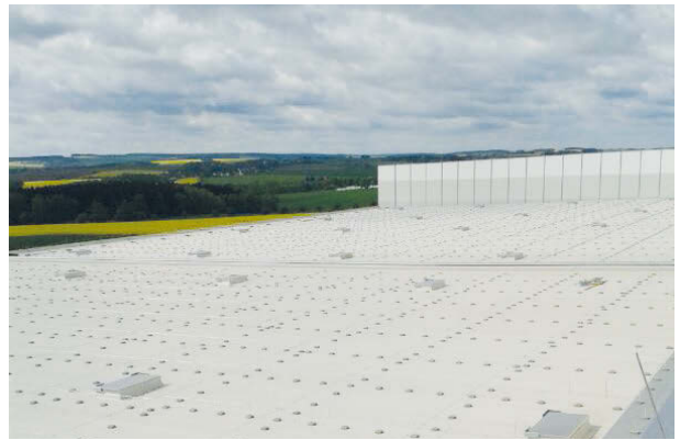
EDEKA Zentrallager, Berbersdorf ExtruPol Dachabdichtung 30.000m 2
