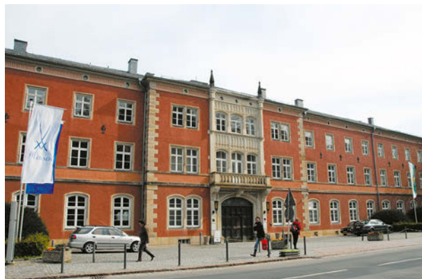
Produktionshalle Porzellanmanufaktur Meissen, Meißen ExtruPol Dachabdichtung, 2.500 m²
