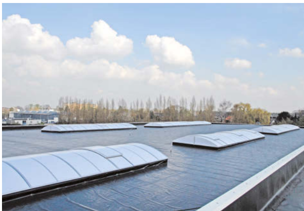
Industriehalle Simpelkamp, Krefeld, ExtruBit Dachabdichtung, 13.000 m 2
