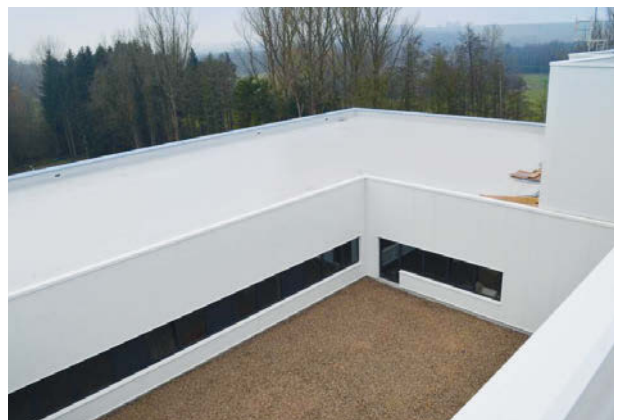
Infineon Warstein, ExtruPol Dachabdichtung, 3.500 m 2
