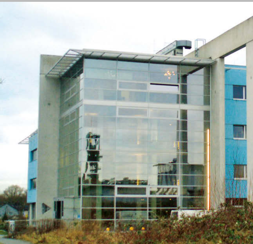
Bürogebäude, Bochum ExtruBit Dachabdichtung, 2.500 m 2
