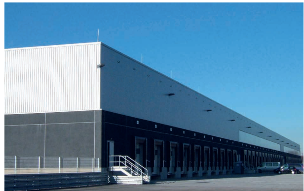
Lidl Logistikzentrum Leverkusen: Extrubit Dachabdichtung, 33.000 m 2
