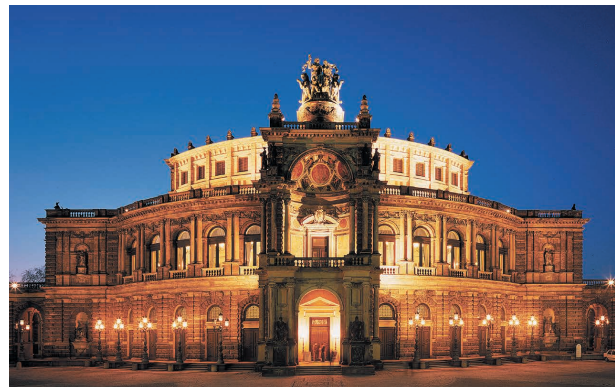
Semper Oper Dresden: ExtruBit Dachabdichtung, 1.800 m 2
