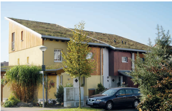
Gründach-Siedlung Bovenden: ExtruBit Dachabdichtung, 850 m 2
