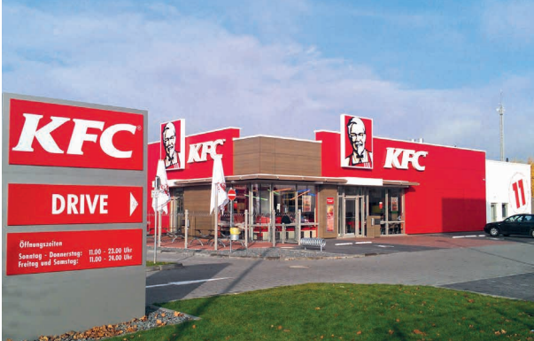
KFC Schnellrestaurant Braunschweig - ExtruPol Dachabdichtung, 500 m 2
