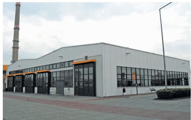
DVB Dresdner Verkehrsbetriebe AG: ExtruBit Dachabdichtung, 10.000 m 2 ; ExtruPol Dachabdichtung,
