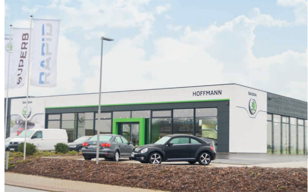
Autohaus Hoffmann in Burgwald, ExtruPol Dachabdichtung 1.000 m 2
