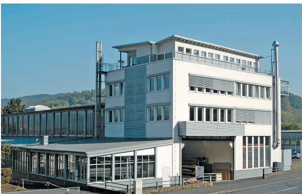
HTT Hann. Münden: ExtruPol Dachabdichtung,
