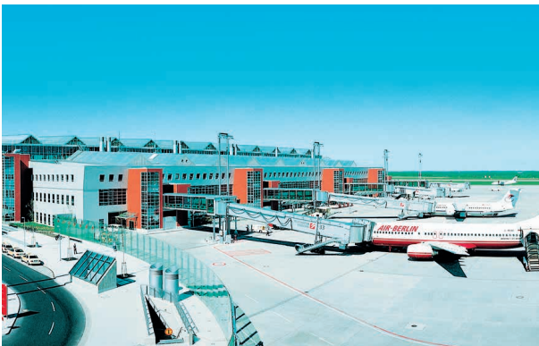
Flughafen Dresden: ExtruPol Dachabdichtung,
